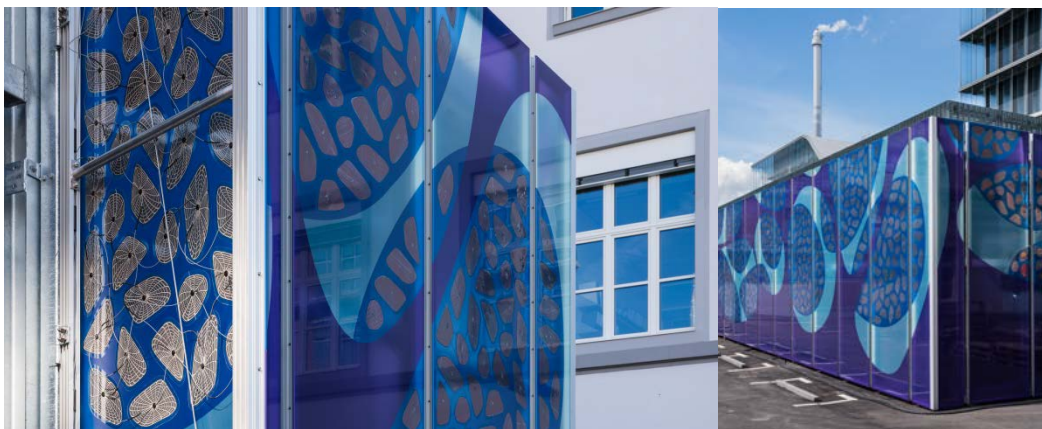
OPV-Module, integriert in farbig-bedruckte, teil-transparente ETFE-Folien.
