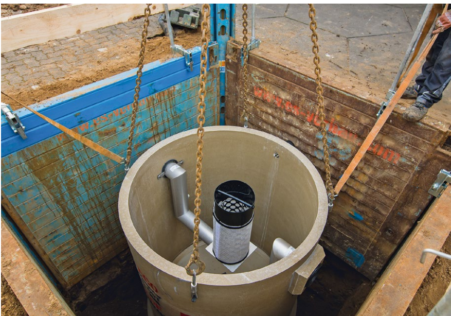
Auch innerhalb der Baugrube lässt sich der Polymerbetonabscheider einfach dirigieren.
