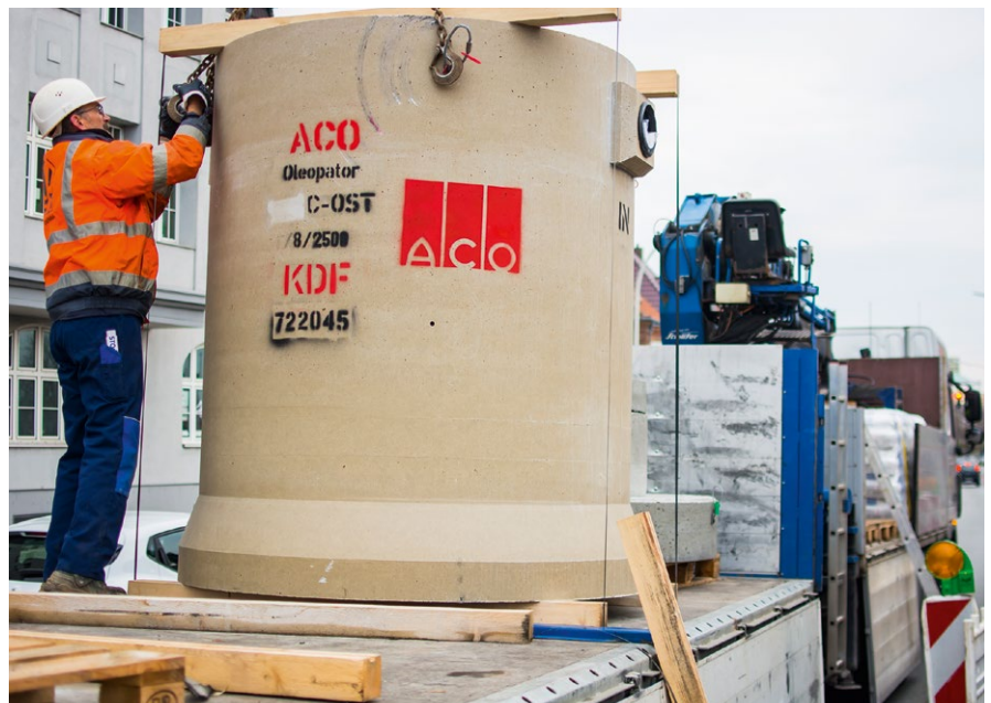
Durch das geringe Gewicht des Polymerbetons kann auf einen Autokran zur Entladung verzichtet werden. Das spart nicht nur Kosten, es erleichtert auch die Logistik an der Baustelle.
