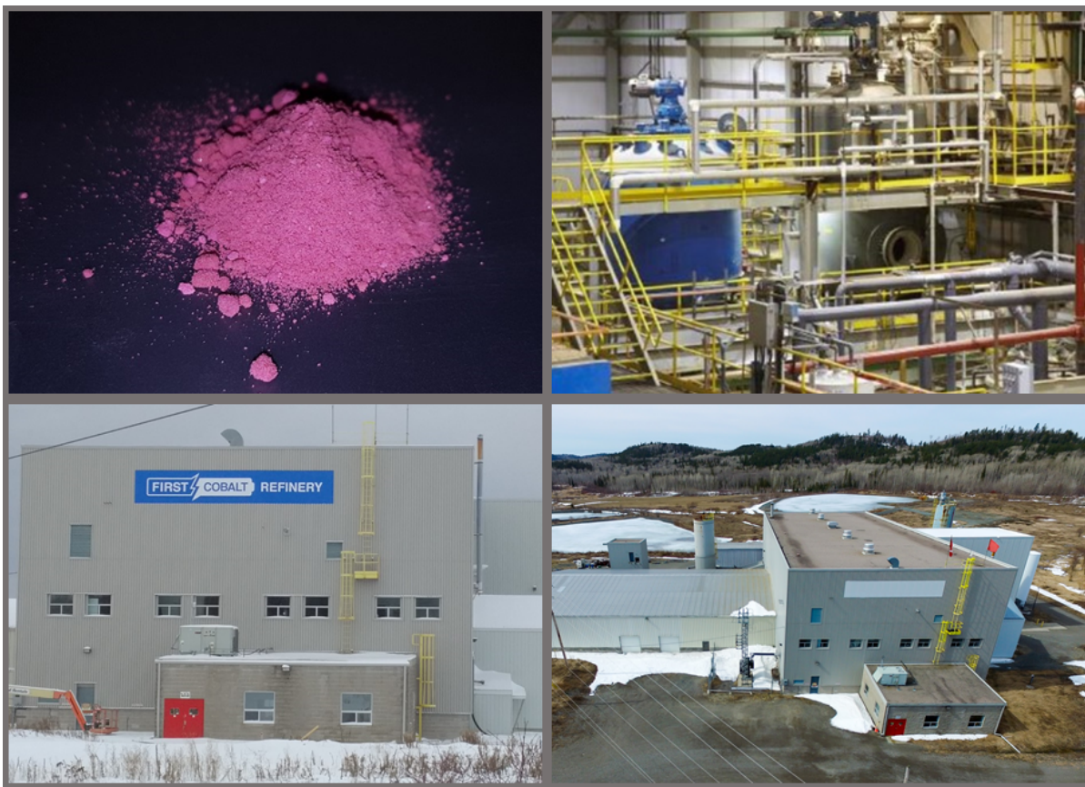
Bild 1. Oben links nach rechts, Kobaltsulfat, hergestellt mit dem Flussdiagramm der Ersten Kobaltraffinerie; aktueller Autoklavkreislauf. Unten von links nach rechts, Außen- und Flächenbilder der Anlage.
