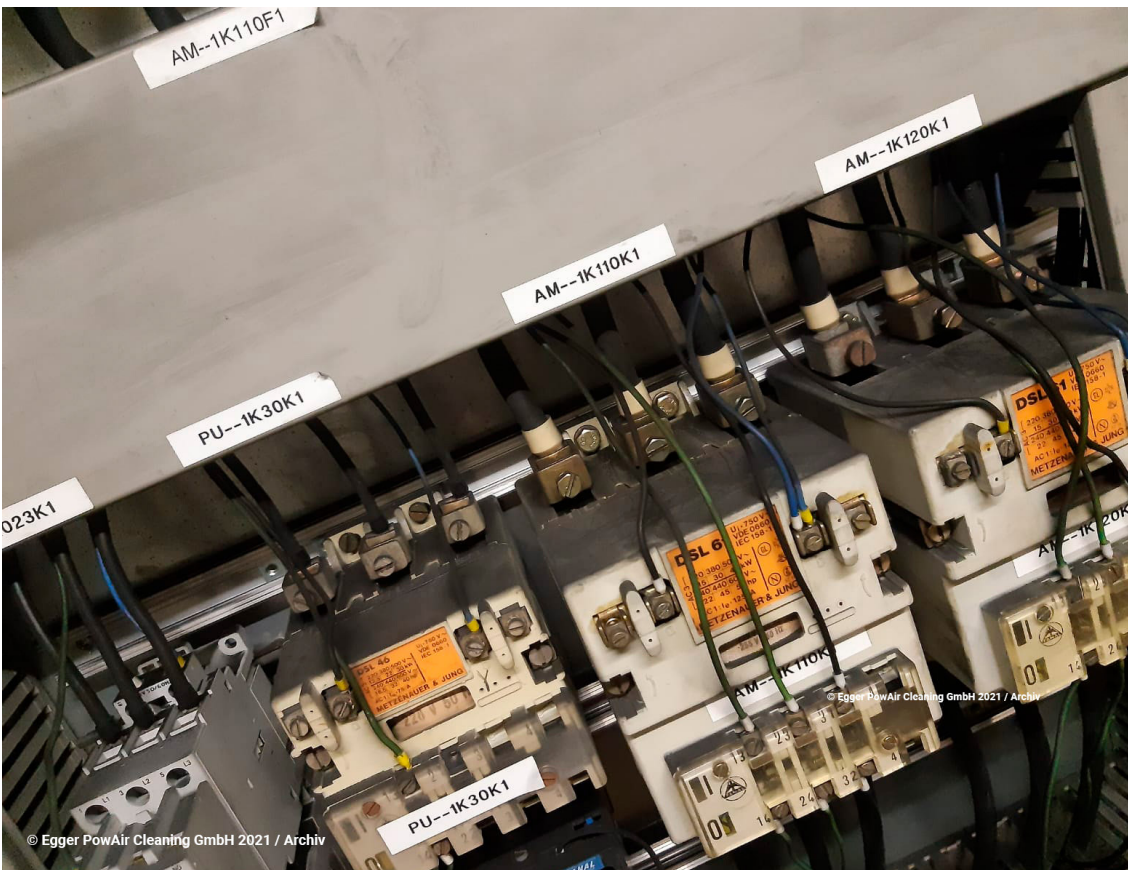
Beschriftungen, die bei Reinigung mit Trockeneis-Pellets oft „wegfliegen“ können. Nicht so bei Reinigung nach dem KDL-Verfahren.
